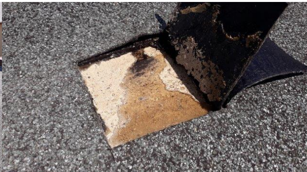
Foto 2 Vytékající voda v sondě nad učebnami
