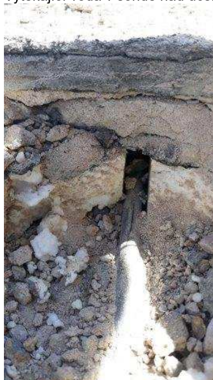
Foto 4 Elektroinstalace v sondě nad tělocvičnou
